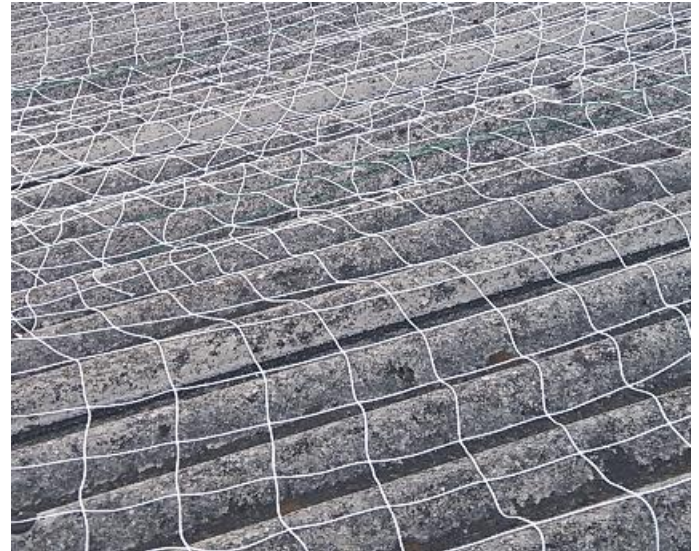
安全ネット取付
