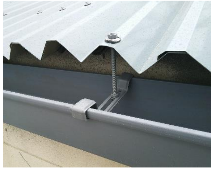
新規 雨樋取付
