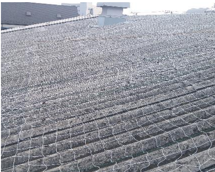
安全ネット取付
