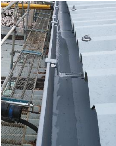
新規 雨樋取付
