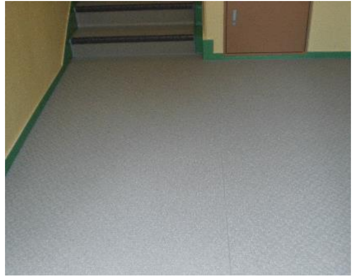
階段踊り場シート張り 完成
