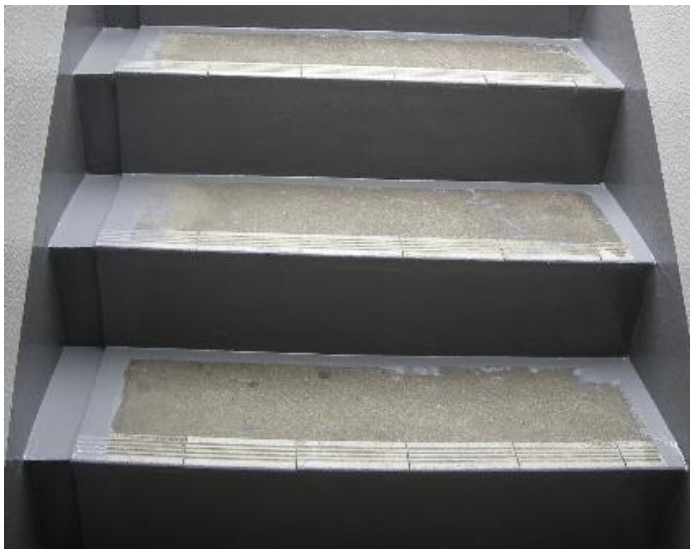
張付けしない部分の塗装
