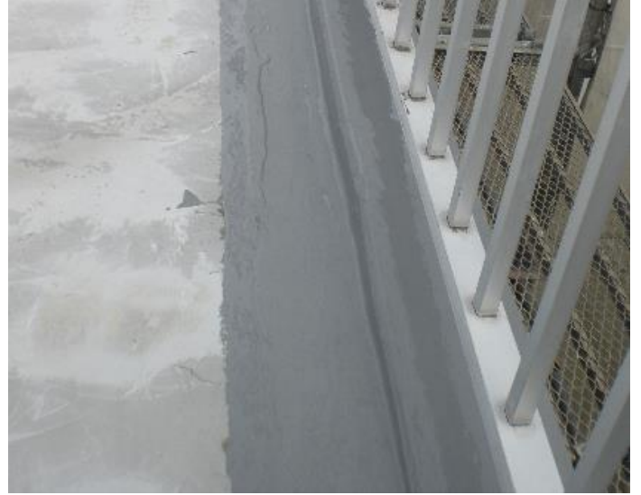
張付けしない部分の塗装
