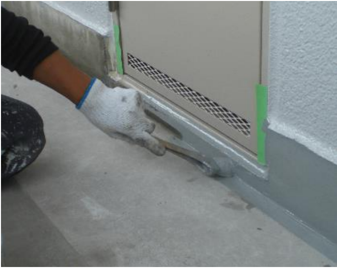
張付けしない部分の塗装
