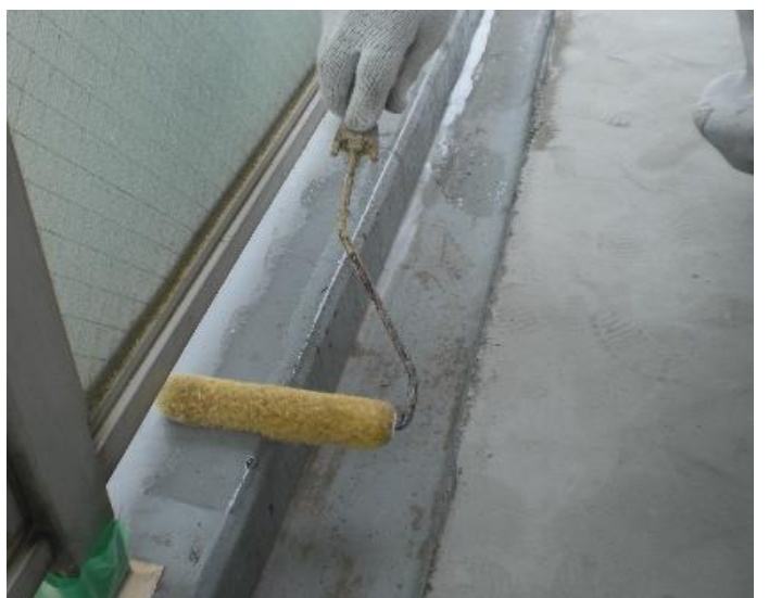
張付けしない部分の塗装
