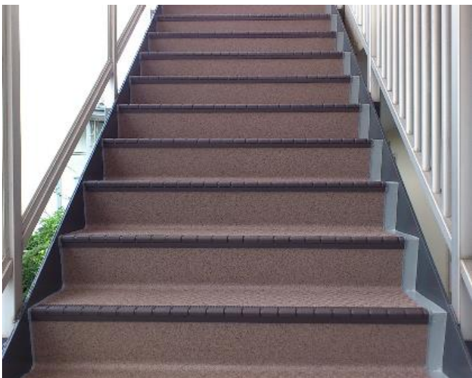
鉄骨階段ステップ張り 完成
