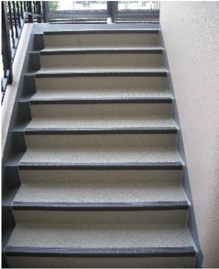
階段ステップ張り 完成
