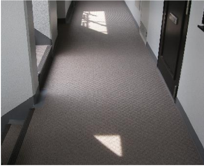
廊下シート張り 完成
