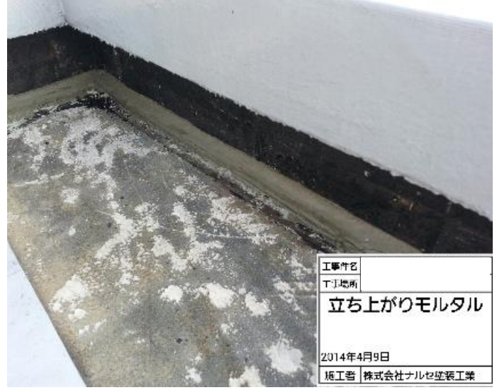
モルタル補修
