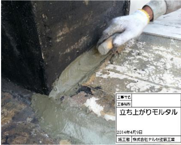
モルタル補修
