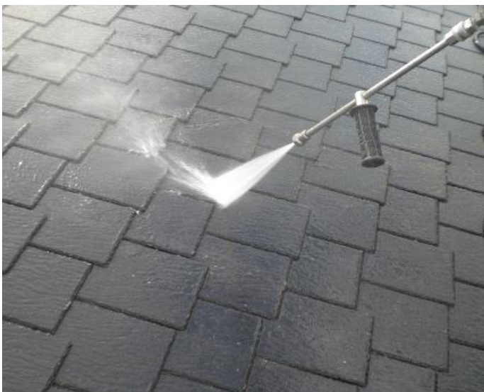
屋根 洗浄工事
