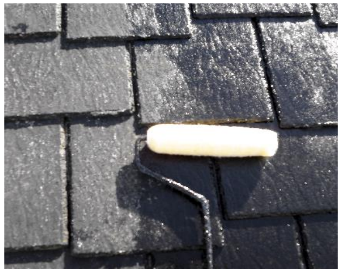
プライマー塗布
