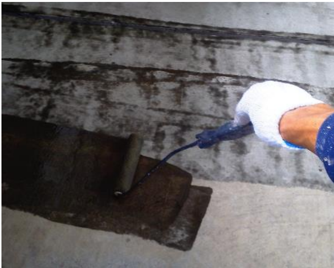
プライマー塗布
