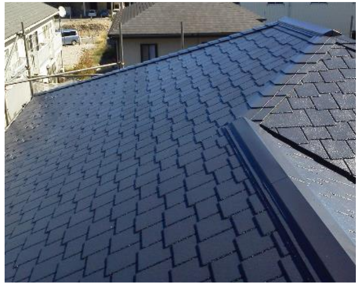
屋根塗装 完了
